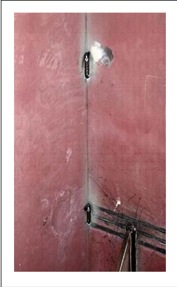
Bild 2: MSG-geschweißte Heftstellen in einem auszuschweißenden Fach einer Sektion
