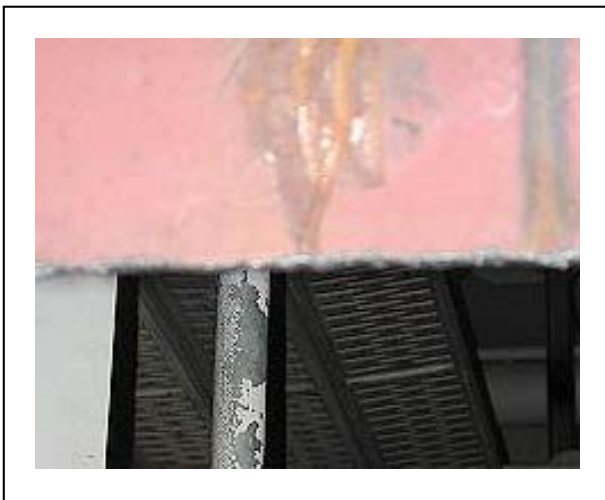
Bild 9: nachträglich in der Ausrüstungsphase eingebrachte Öffnung
