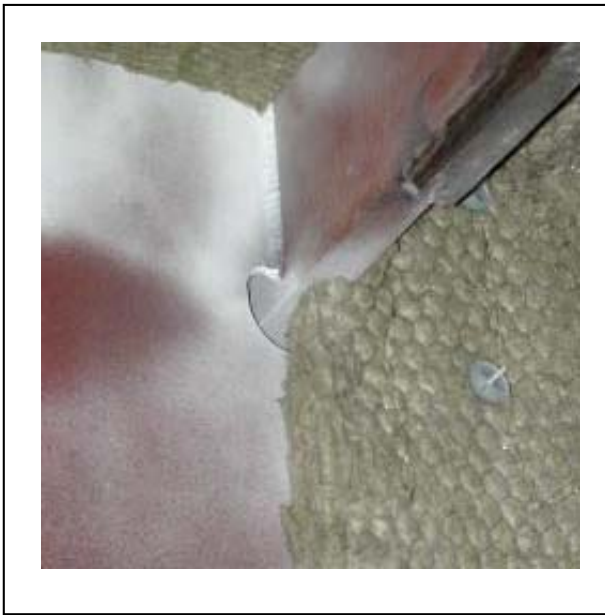
Bild 5: Beispiel für einen Bereich mit Dämmung, in dem beim nachträglichen Schweißen besondere Vorsicht geboten ist
