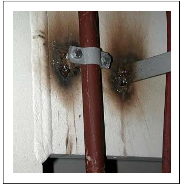
Bild 6: Nachträglich angeschweißte Rohrhalter auf bereits endkonservierter Wand
