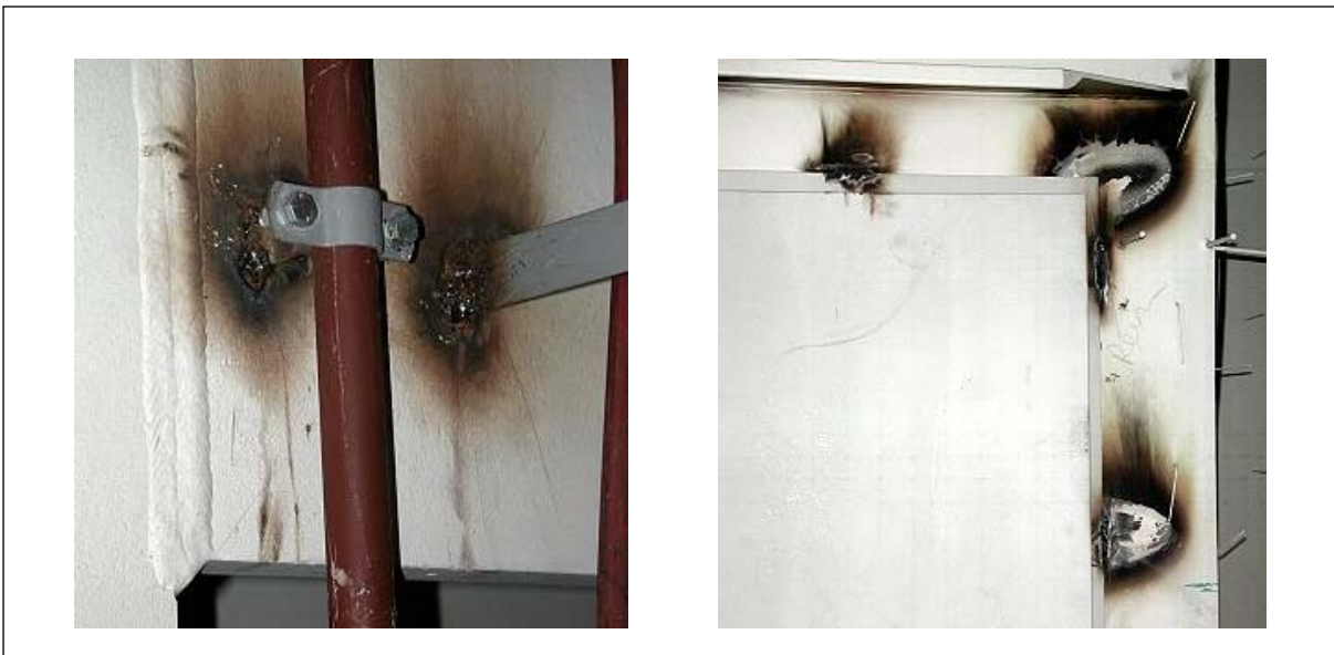
Bild 5: links: Nachträglich angeschweißte Rohrhalter auf bereits endkonservierter Wand; rechts: Nachträglich eingeschweißter Türrahmen auf endkonservierter Wand
